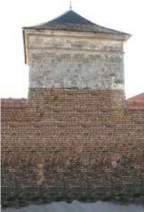
Coté parking à ouvrir
