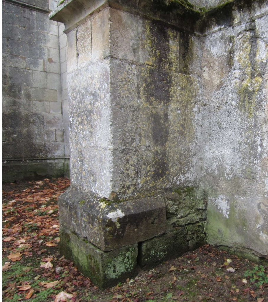
Contrefort façade nord
