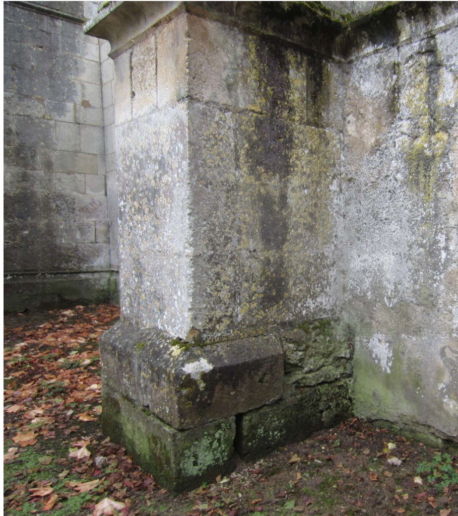
Contrefort façade nord
